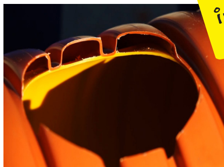
2 Realizzazione del foro 2 Bore a hole
