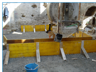
3 Preparazione del cordolo 3 Ring beam construction
