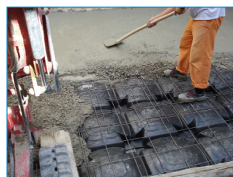
8 Posizionamento rete metallica + massetto 8 Final installation of electro welded net + concrete pouring
