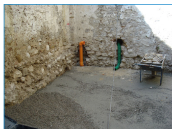
2 Gettata preparatoria di cemento 2 Concrete pouring
