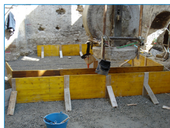
3 Preparazione del cordolo 3 Ring beam construction
