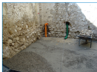
2 Gettata preparatoria di cemento 2 Concrete pouring
